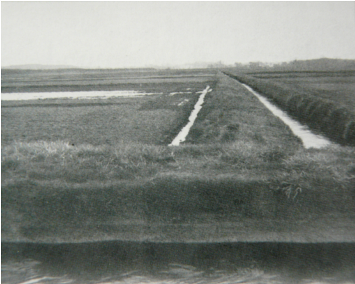
Bild: Tiefbauamt Dortmund
